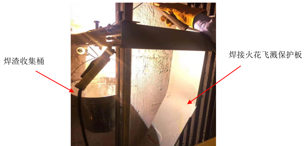
焊接火花或焊渣保护工具的实例
